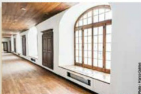
Les grandes fenêtres cintrées du déambuloire du couvent des Augustines ont été fabriquées selon le modèle d'origine par Menuiserie Authentique.
