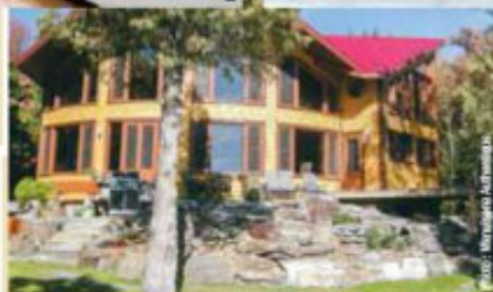
Menuiserie Authentique fabrique aussi des portes et des fenêtres pour des constructions contemporaines.
